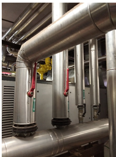
Collettore e tubazioni di mandata Acqua Calda Sanitaria
