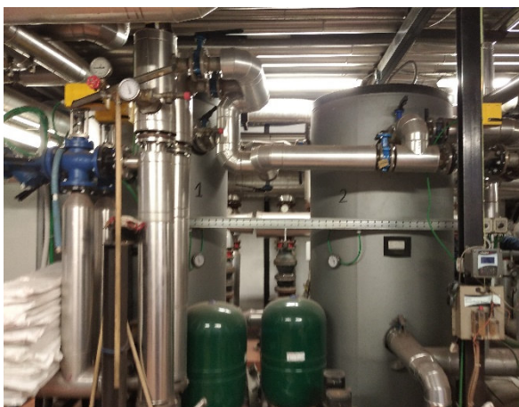
Generatori Acqua Calda Sanitaria in Centrale Termica
