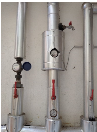
Centrale Idrica con particolari costruttivi del collettore di mandata Acqua Fredda Sanitaria
