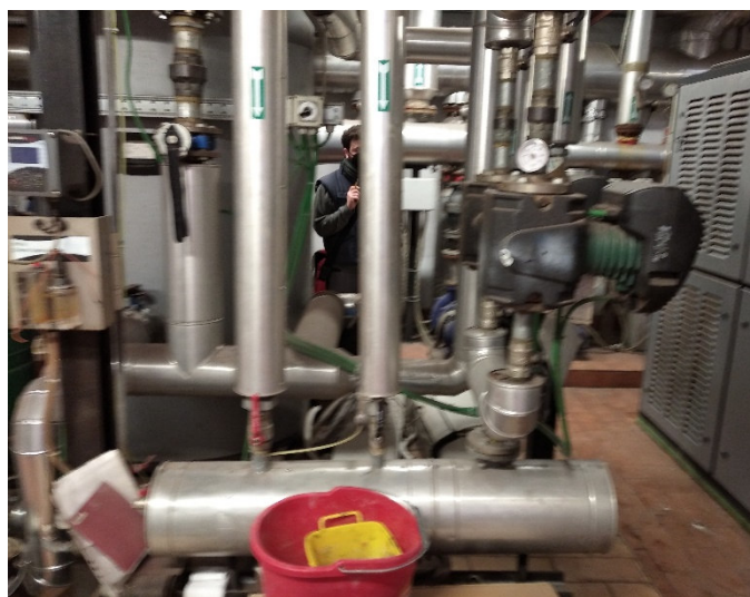
Collettore e tubazioni di ricircolo Acqua Calda Sanitaria
