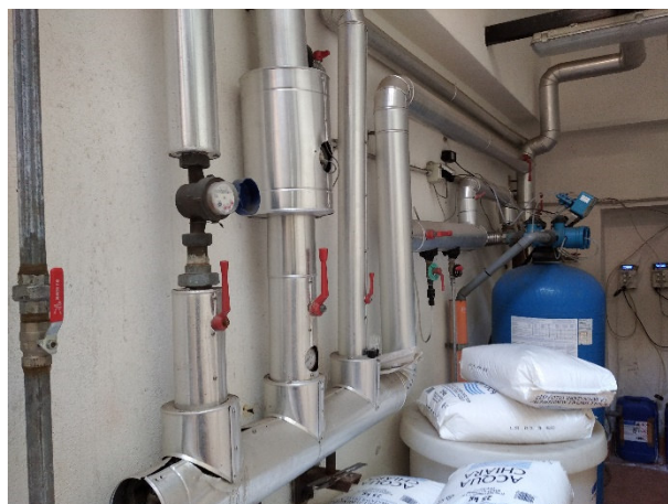
Impianto di Addolcimento acqua fredda di reintegro ai boiler
