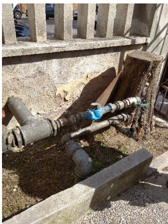
Punto di presa e contatore dell'Acqua Fredda Sanitaria
