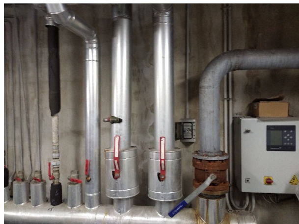
Centrale Idrica con evidenza del collettore di mandata Acqua Fredda Sanitaria
