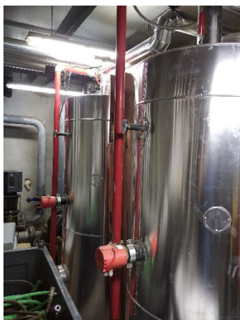
Generatori Acqua Calda Sanitaria in Centrale Termica
